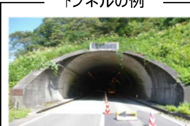
トンネルの例
