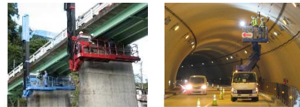
橋梁点検 (点検車) トンネル点検
