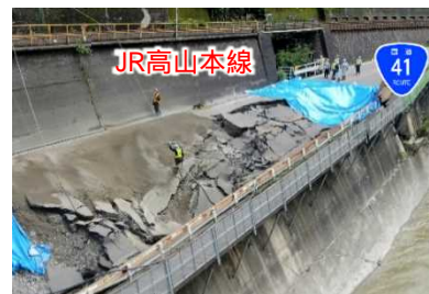
<JR高山本線擁壁部分補強工事>
