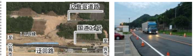
広島県道路・国道31号の被害状況
