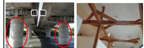
<橋梁の耐震対策> <道の駅の耐震対策>
