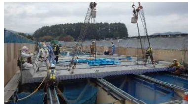
<床版取替工事の状況>
