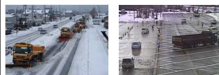
<除雪機械の増強> <チェーン着脱場>
