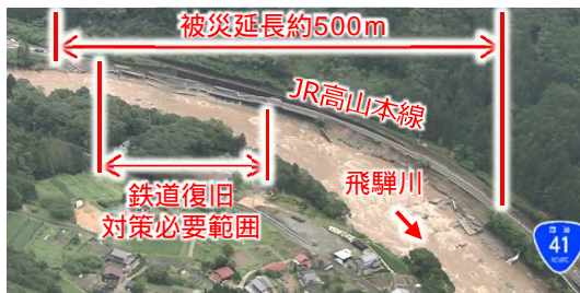
<護岸洗掘による国道41号の被災状況>
