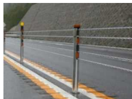
<ワイヤロープの設置事例>
