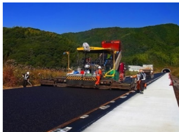
付図 1.1.3.1 コンポジット舗装の施工状況
