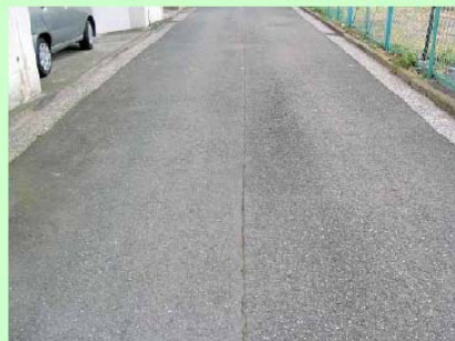
舗装の施工継ぎ目
