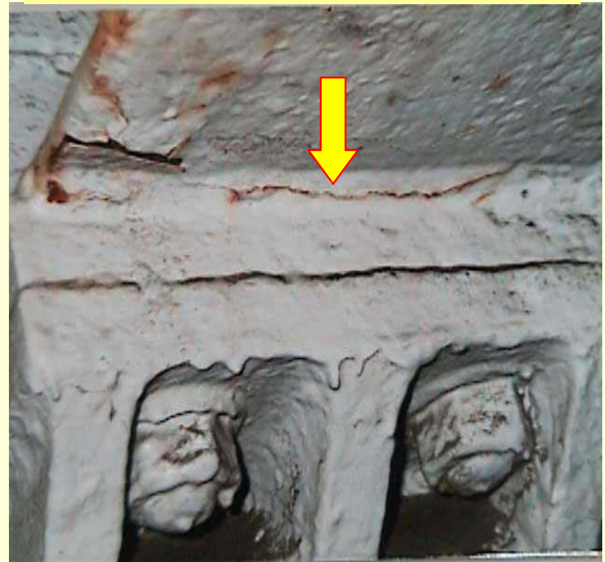
昭和41年架設・ゲルバー鋼I桁
