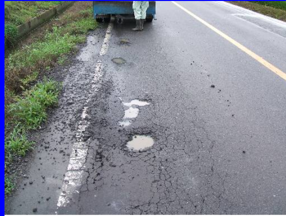
ポーラスアスファルト 舗装の部分的な寄り
