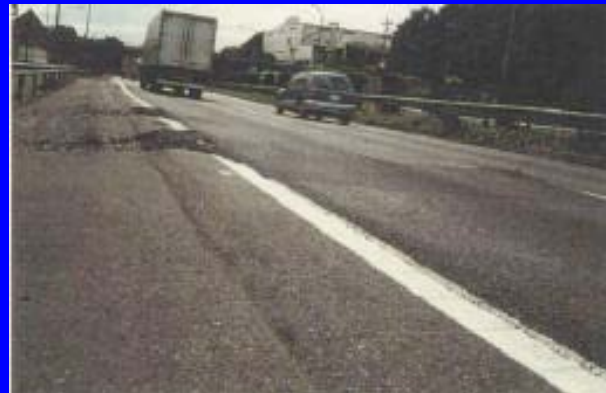
ポーラスアスファルト 舗装の部分的な寄り
