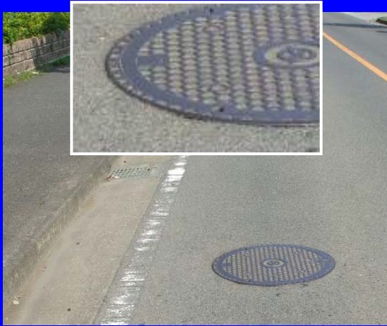
ポーラスアスファルト 舗装の骨材飛散
