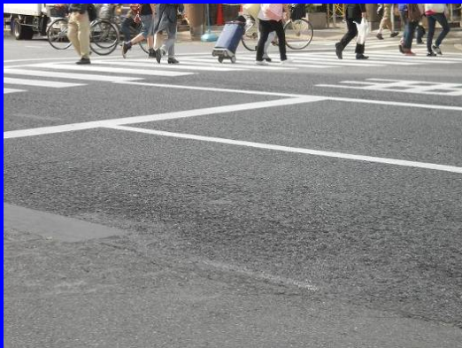
ポーラスアスファルト 舗装の骨材飛散
