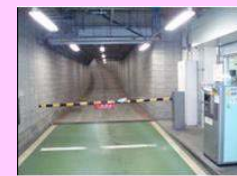
<札幌> 【北一条地下駐車場】
