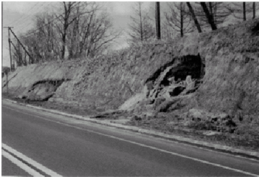
写真 3-5 融解期における切土のり面の被災例
