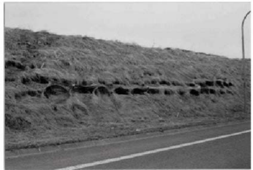
写真 3-6 凍上による切土のり面の軽量のり枠の被災例
