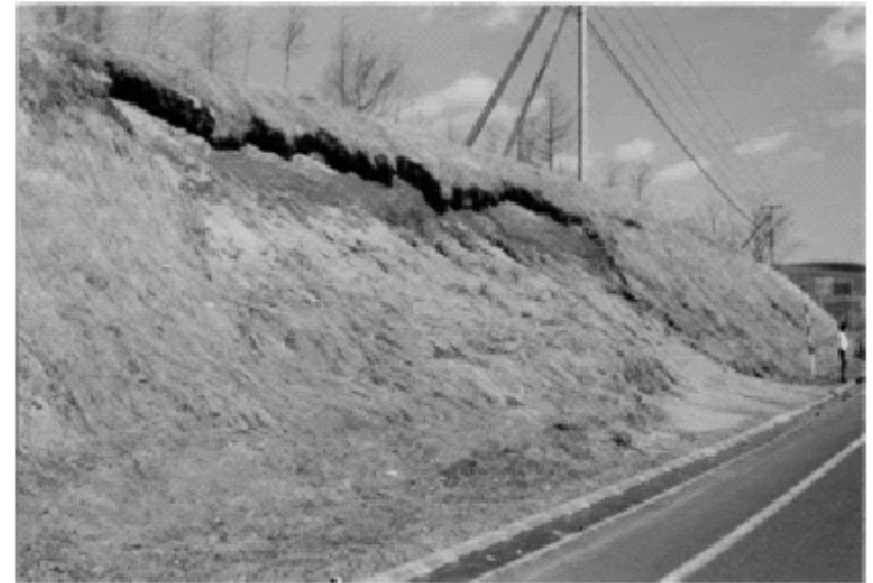
写真 3-5 融解期における切土のり面の被災例
