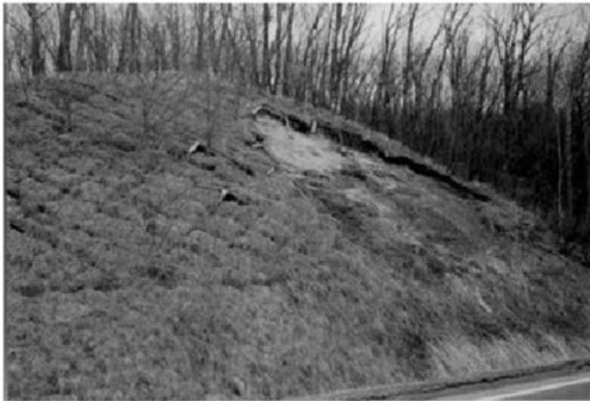
写真 3-6 凍上による切土のり面の軽量のり枠の被災例
