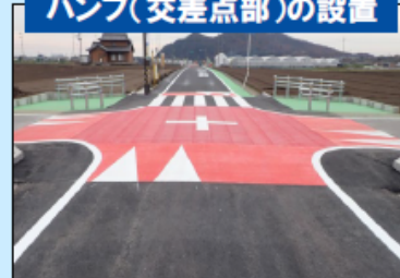
ハンプ(交差点部)の設置
