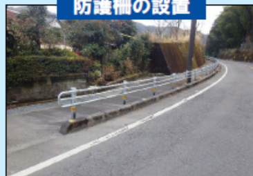
防護柵の設置
