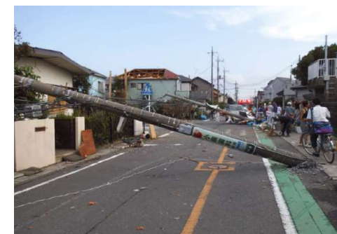
竜巻における電柱倒壊例
