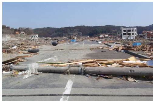
電柱倒壊例（東日本大震災）
