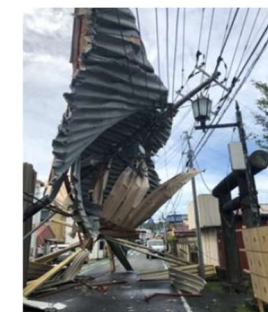
飛来物による電柱倒壊例（令和元年台風15号）
