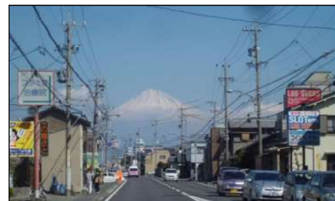
<美観を損ねる電柱・電線>
