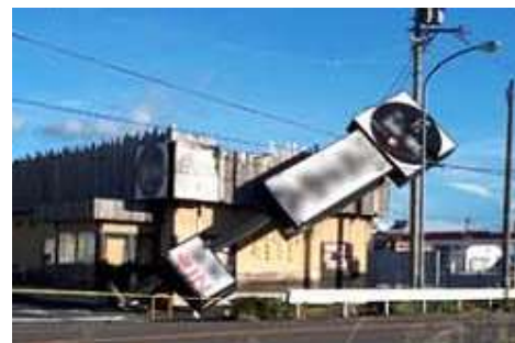
広告塔倒壊例（H30年台風24号）
