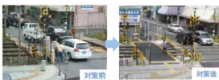
踏切拡幅（歩道新設）の例
