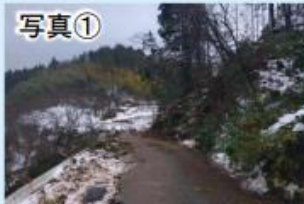
県道38号緊急復旧完了状況
