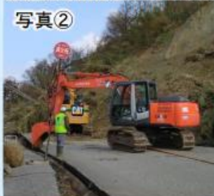
国道249号緊急復旧作業状況
