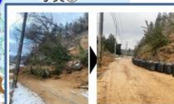
土砂崩落復旧前 土砂崩落復旧後
