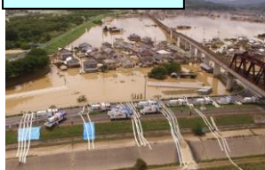
【 H30.7月豪雨 】 (岡山県倉敷市真備町)
