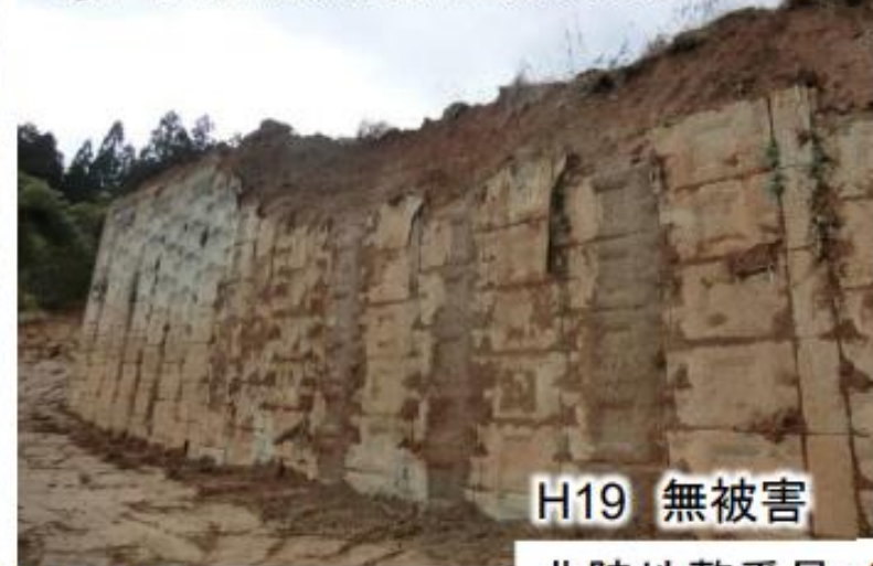
③壁面材(残存部)に変状なし
