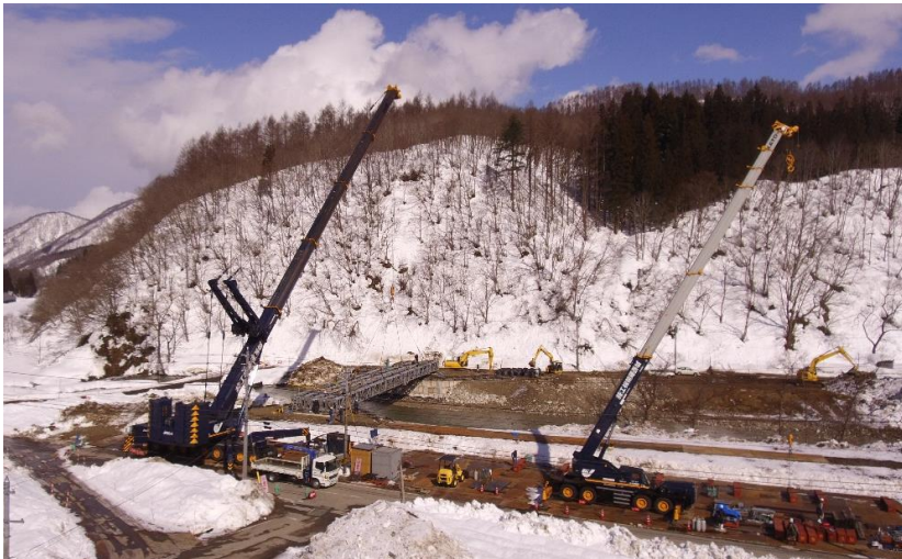
■地滑り災害による災害復旧支援(富山県:県道上百瀬島地線 L=40m 133t)
