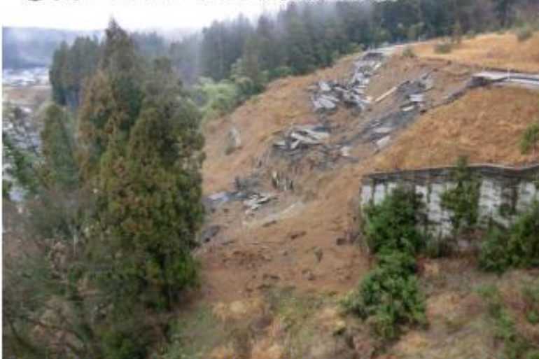
②嵩上げ盛土の大規模崩壊
