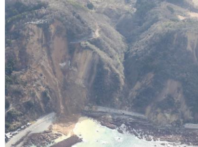
写真② 国道249号法面崩落 (R6.1.2撮影)
