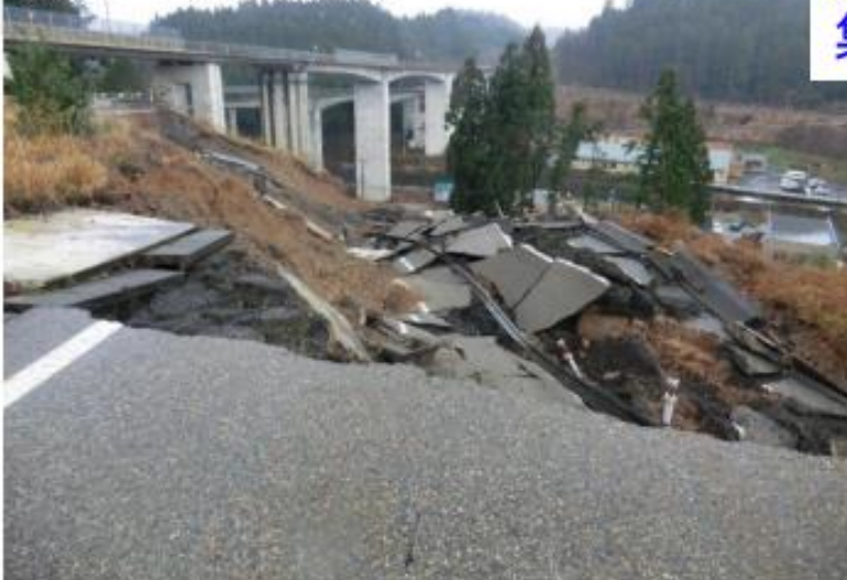
②嵩上げ盛土の大規模崩壊
