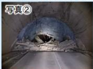
国道249号中屋トンネル崩落状況
