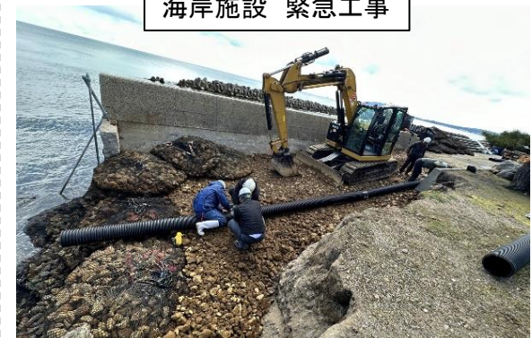
海岸施設 緊急工事
