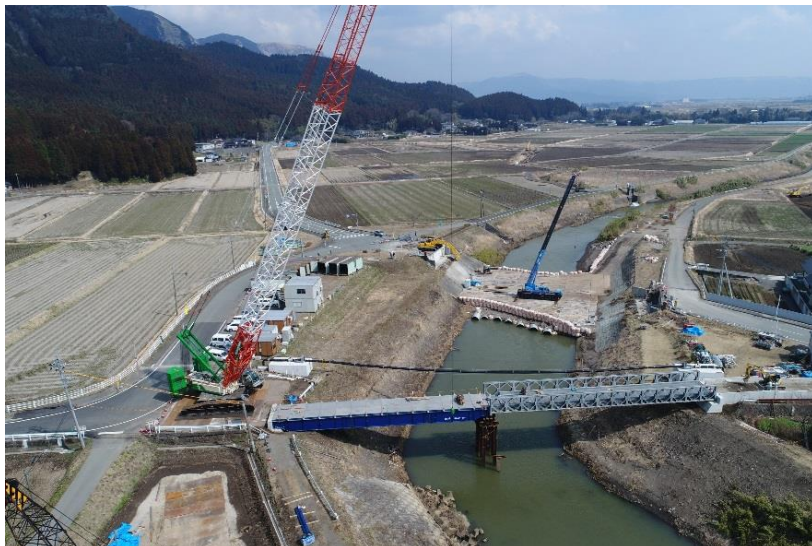
■熊本地震による落橋に伴う災害復旧支援(熊本県:県道149号 L=30m 73t)
