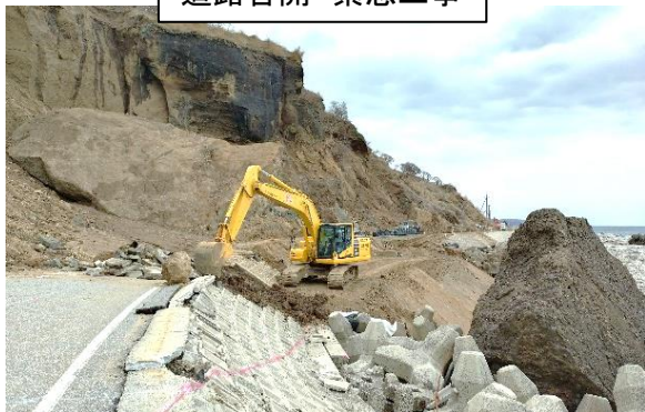
道路啓開 緊急工事
