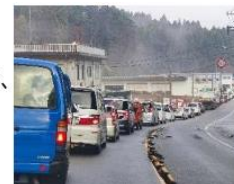
▲被災直後の国道249号 (穴水町乙ヶ崎)
