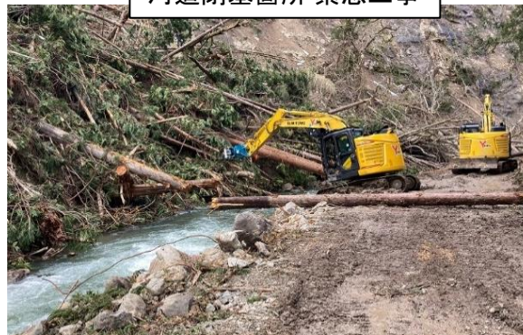
河道閉塞箇所 緊急工事
