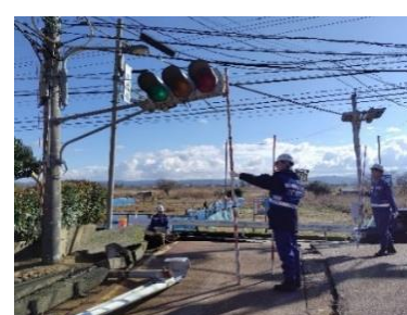
道路の被災状況調査 (石川県内灘町)
