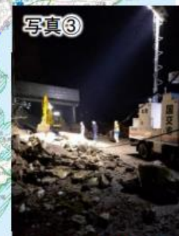
大型車の通行確保に向けた緊急復旧作業状況
