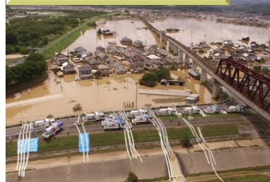
【H30.7月豪雨】 (岡山県倉敷市真備町)
