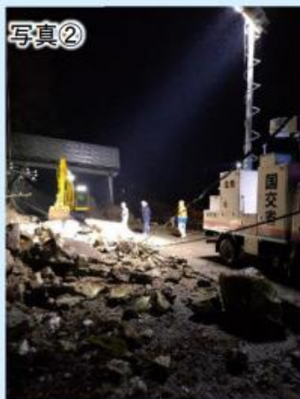
大型車の通行確保に向けた緊急復旧作業状況
