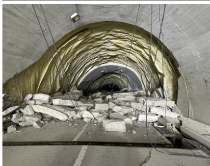
国道249号大谷トンネル（珠州市）
