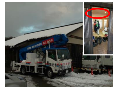
避難所へ照明車からの電源支援 (石川県輪島市)
