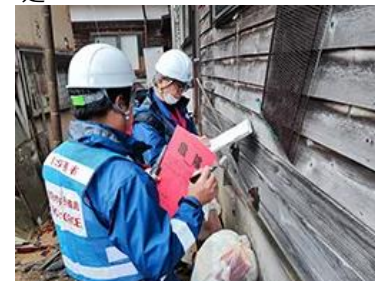
被災建築物応急危険度判定 (石川県穴水市)
