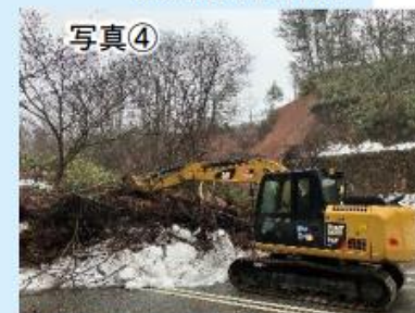
大型車の通行確保に向けた緊急復旧作業状況
