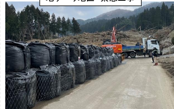
地すべり地区 緊急工事
