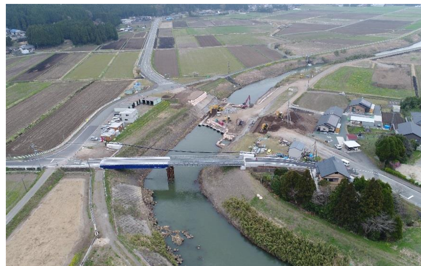
■熊本地震による落橋に伴う災害復旧支援(熊本県:県道149号 L=30m 73t)
