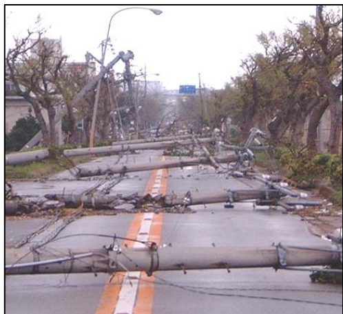
<電柱の倒壊による道路閉塞>
