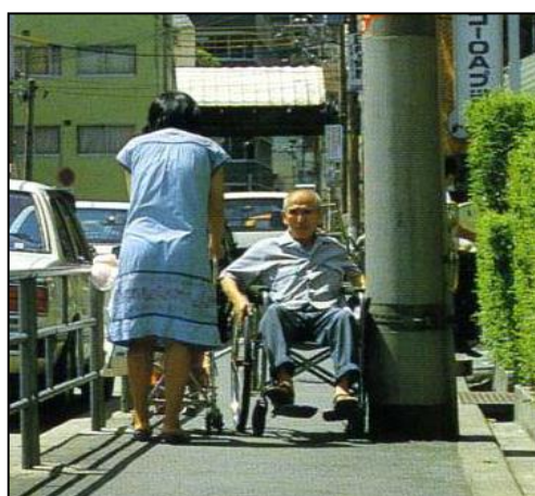
<歩行の支障となる電柱>
