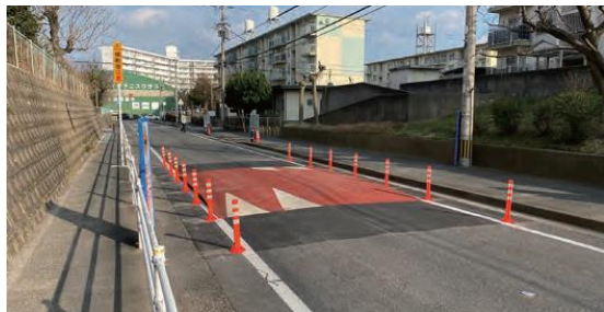
ハンプの試験設置の様子
