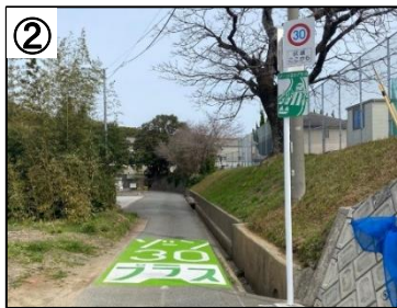
ゾーン30プラス看板・路面表示
