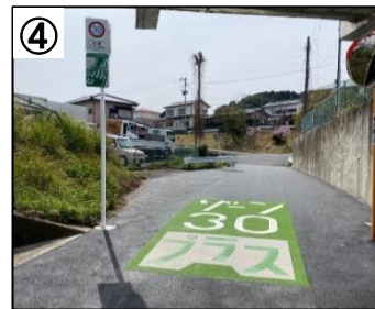
ゾーン30プラス看板・路面表示
