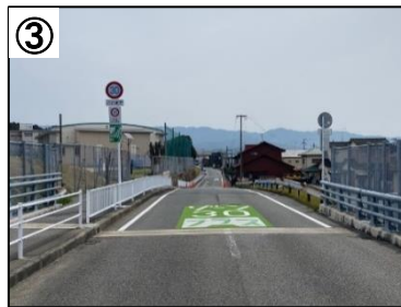
ゾーン30プラス看板・路面表示
