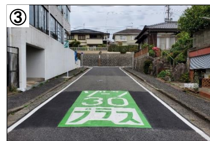
ゾーン30プラス看板・路面表示
