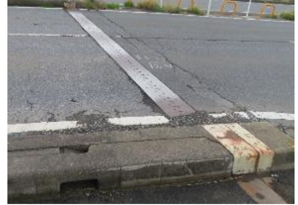
伸縮装置の状態
