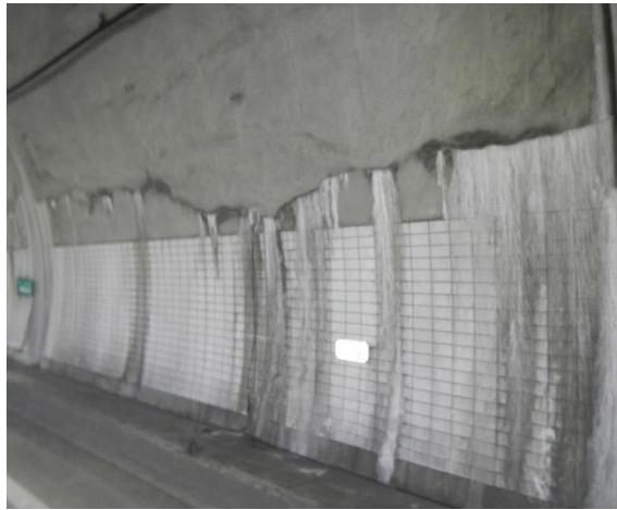
覆工側壁部の状態
