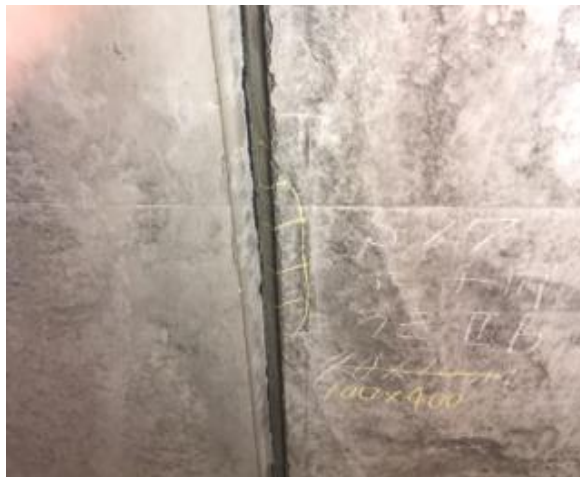
覆工アーチ部 横断目地部の状態
