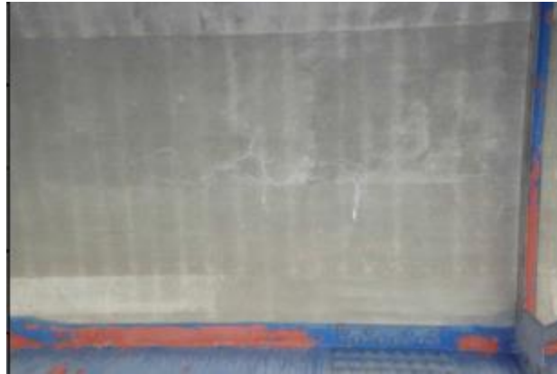
床版下面の状態
