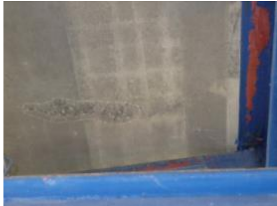
床版下面の状態
