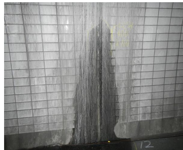
覆工側壁部 横断目地部の状態
