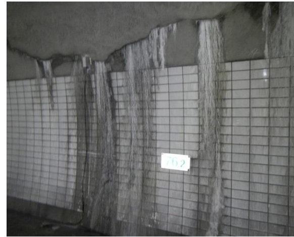
覆工側壁部の状態
