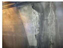
▲トンネル目地部
