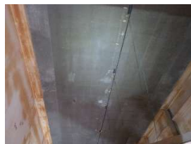
光ファイバーセンサーによる 橋梁モニタリング
