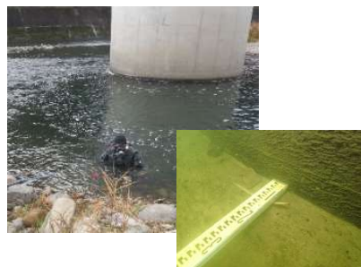
潜水調査による河床洗掘の把握
