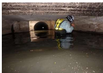
滞水した溝橋内部の目視点検
