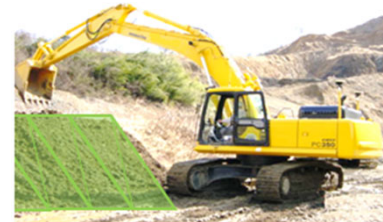
ICT施工の活用
