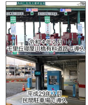
ETC多目的利用システム活用事例
