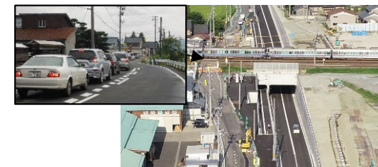
単独立体交差化による渋滞解消（半田踏切道（福井県福井市）） ※踏切は既に閉鎖しており、今後除却予定
