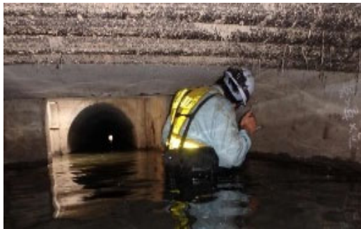
滞水した溝橋内部の目視点検
