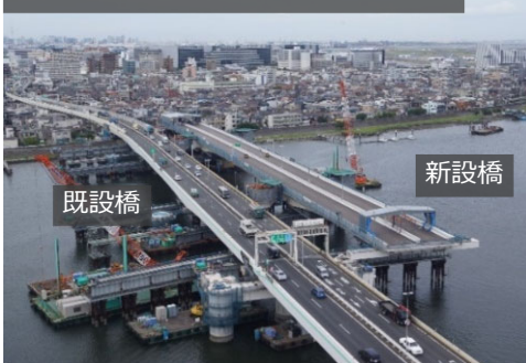
①新設橋設置前（撮影日：R5.5.26）
