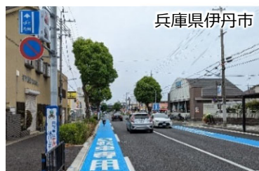
兵庫県伊丹市 自転車専用通行帯の整備
