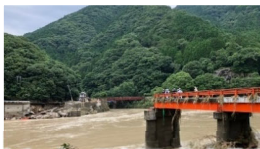
令和2年7月豪雨...熊本県道
