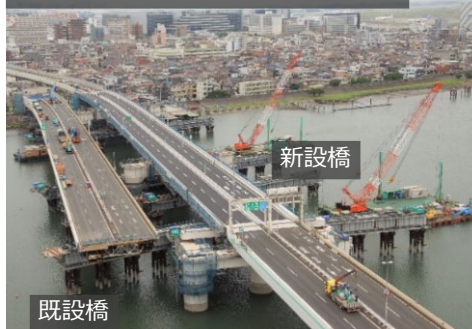
②新設橋設置後（撮影日：R5.6.8）
