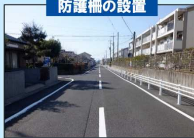
防護柵の設置
