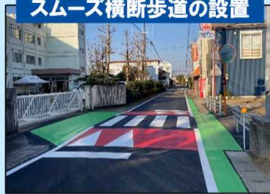
スムーズ横断歩道の設置
