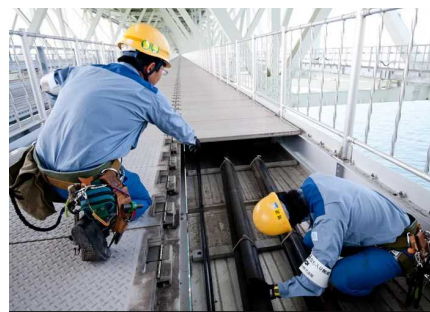
出典:関西電力送配電HP (明石海峡大橋に添架されている電力ケーブル)
