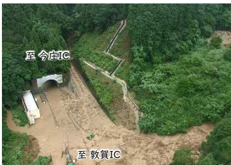
【R4.8月】北陸自動車道 土砂流入 (福井県敦賀市)
