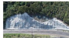
法面吹付工、落石防止網工
