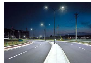
LED照明による省エネ効果 消費電力約6割削減 (高圧ナトリウム灯比) 出典：令和3年度 道路分科会 基本政策部会資料
