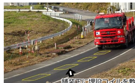
舗装下に埋設コイルを敷設
