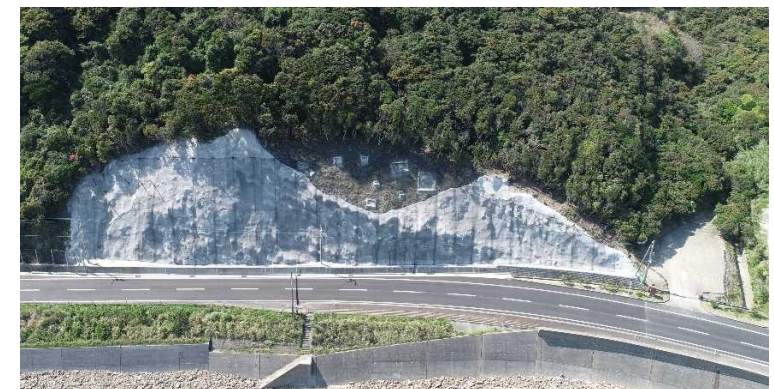
法面吹付工、落石防止網工
