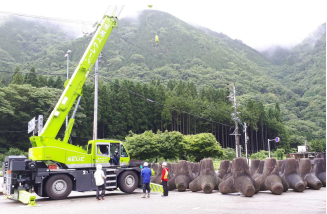
道路崩壊に対応するための資機材の保管場所 令和2年 7月豪雨
