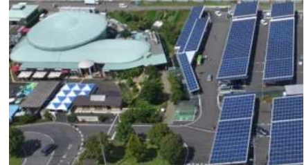
太陽光発電施設の設置
