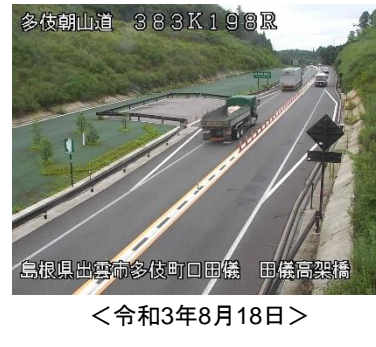
【E9山陰自動車道(迂回状況)】
