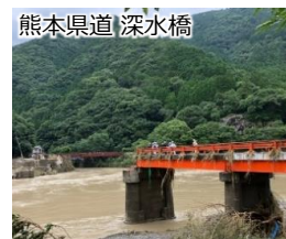
橋梁流失 令和2年7月豪雨 (6ヶ月以上の通行止め)
