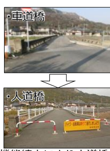
機能縮小により人道橋としてリニューアル ※車両は60m先の橋梁を利用
