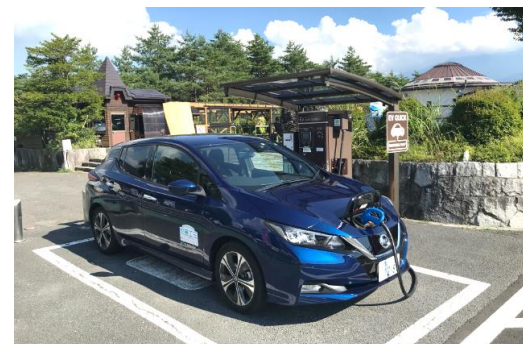
< 道の駅でのEV充電器の設置 >
