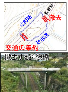
老朽化が進展した跨線橋を撤去し隣接橋へ機能を集約
