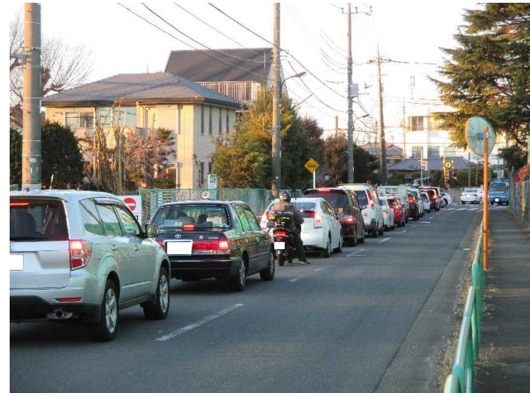
かみいぐさ 東京都練馬区 上井草第2号踏切 (開かずの踏切、自動車ボトルネック、歩行者ボトルネック) (西武鉄道／新宿線)の遮断による渋滞状況
