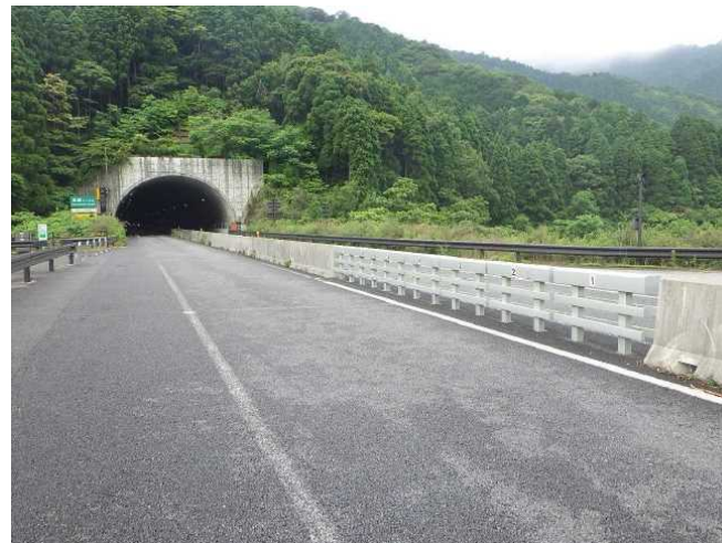
<<E10東九州道の非常開口部の防護柵>>
