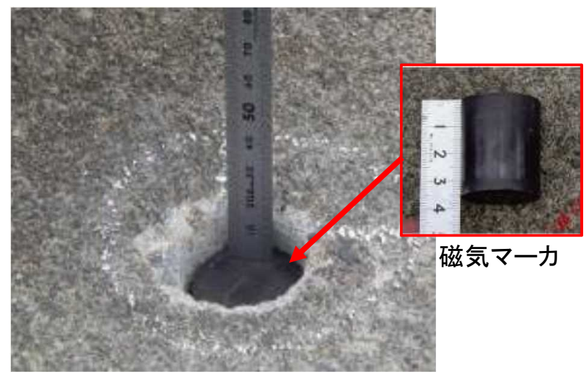
▲磁気マーカ設置
