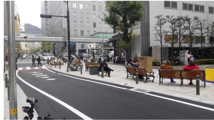
葺合南54号線歩道を拡幅しベンチを設置（兵庫県神戸市）
