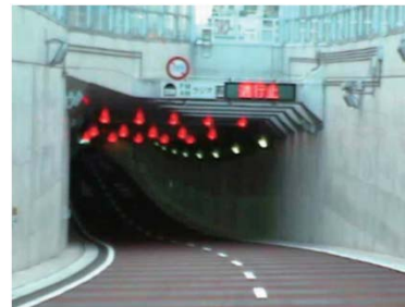
坑口部フラッシング**
