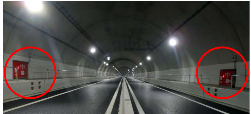
中央分離帯に剛性防護柵が 設置されたトンネル
