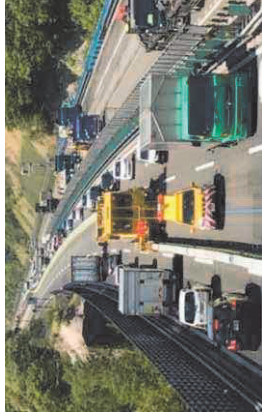
＜移動式防護柵による車線切替状況＞
