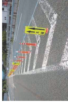
公募技術による逆走対策の展開（LED発光体ラバーポールによる誘導）
