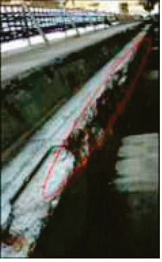
コンクリートの剥離、鉄筋腐食
