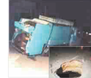
下水道の老朽化による道路陥没
