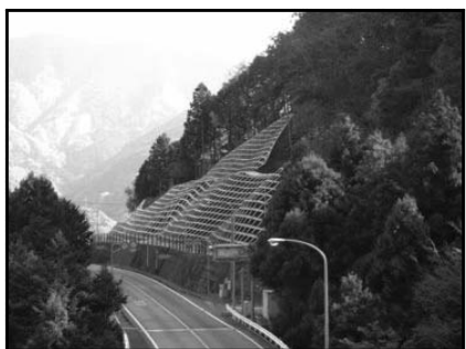
<斜面崩落防止対策>
