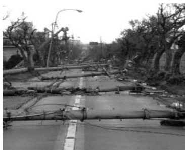
<電柱の倒壊による道路閉塞>
