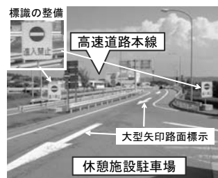
<高速道路の逆走対策> (標識、大型矢印路面標示の整備)
