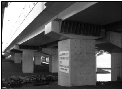
<橋梁の耐震補強>
