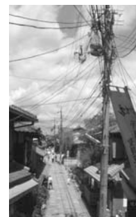
< 美観を損ねる電柱・電線 >
