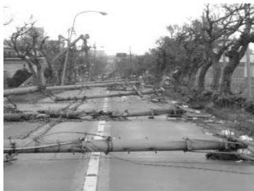
< 電柱の倒壊による道路閉塞 >
