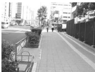
＜幅の広い歩道の整備や視覚障がい者誘導用ブロックの設置＞
