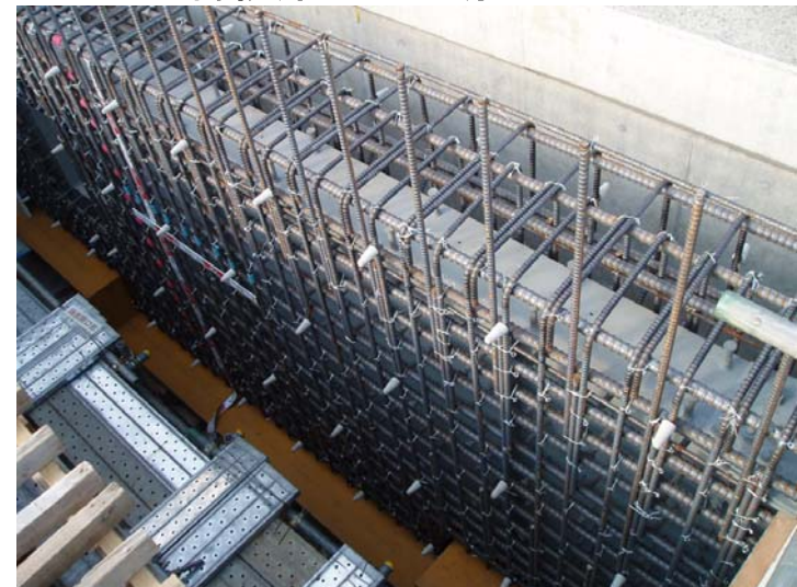
＜端横桁の配筋状況＞
