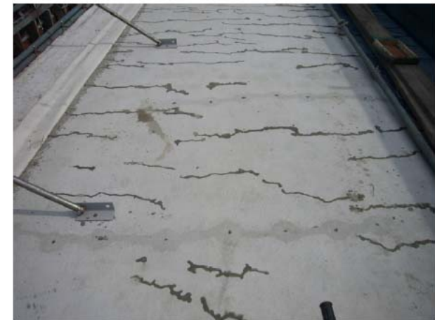
(樹脂注入後の外観)
