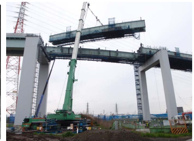
自走大型クレーン
