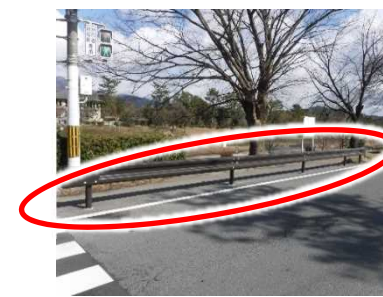
【防護柵の設置】
