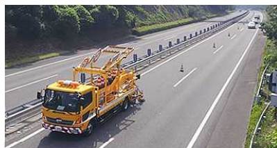
<規制機材の自動設置状況>
