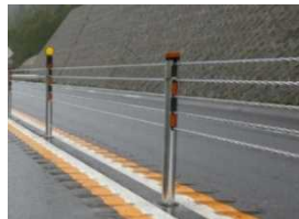
<ワイヤロープの設置事例>
