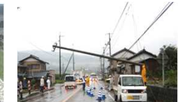
沿道の電柱の倒壊による道路閉塞
