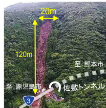
復旧までに14日間 <国道3号(熊本県)>
