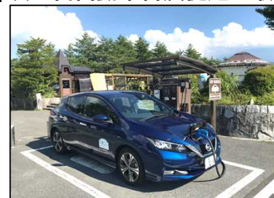
<道の駅でのEV充電器の設置>
