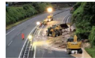
<九州自動車道(横川~溝辺鹿児島空港)>
