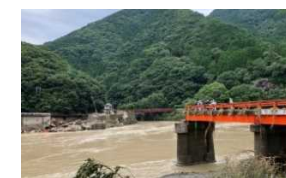
熊本県道の被害状況
