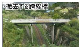
老朽化が進んだ跨線橋を撤去し隣接橋へ機能を集約
