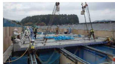
<床版取替工事の状況>
