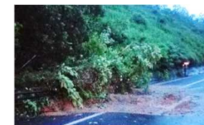
<南九州西回り自動車道(八代-水俣)>
