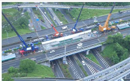
<終日通行止めによる更新事例>
