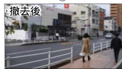
老朽化した横断歩道橋を撤去しバリアフリーな歩道空間を確保
