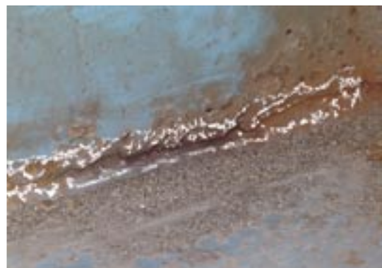
写真-1.13 腐食と同時に亀裂を生じた例 (注: 亀裂箇所をチョークでマーキングしている)
