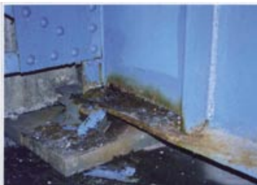
写真-1.4 桁端部 支承部周辺での滞水、塵埃等の堆積による腐食の例
