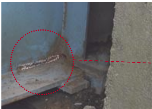
写真-1.13 腐食と同時に亀裂を生じた例 (注: 亀裂箇所をチョークでマーキングしている)
