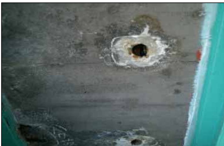
位置: 床版穴有り(水抜き?) 撮影日:
